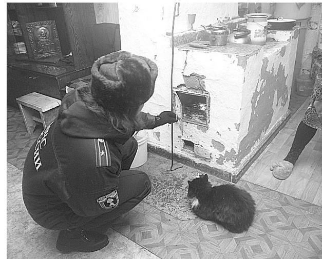
В местах пересечения дымовых труб со сгораемыми конструкциями расстояние от внутренней поверхности дымовых каналов до этих конструкций должно быть не менее 38 см. Для защиты сгораемого и трудноогораемого пола перед топкой печи следует предусмотреть металлический лист размером 70x50 см толщиной не менее 2мм, предохраняющий от возгорания случайно выпавших искр.
