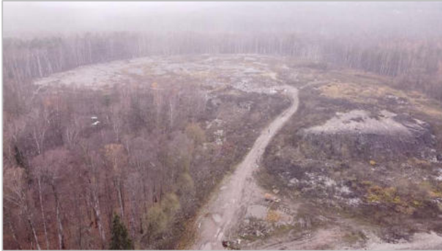
Рисунок 3.1.5 – Территория участка рекультивации (дата съемки: 01.11.2022 г.)
